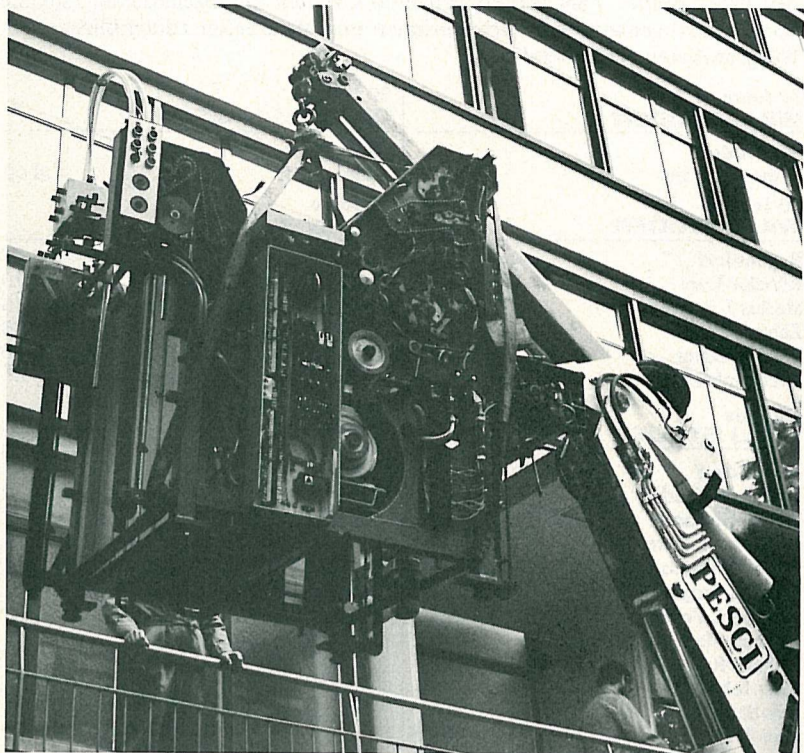
Druckmaschinen-Züglete . . . ein Vorhaben, das laufend neue Situationen bringt, oder wie werden 1450 kg Maschine geliefert und plaziert.
